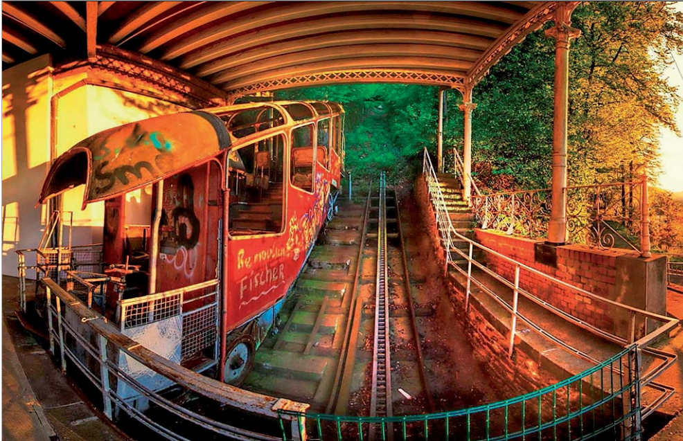
Der Waggon, der eigentlich nur noch wie ein Haufen Schrott aussah, ...
