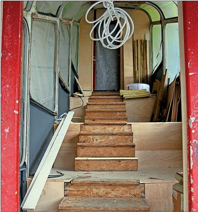
Bald wird auch der originalgetreue Holzinnenbau fertiggestellt sein.
