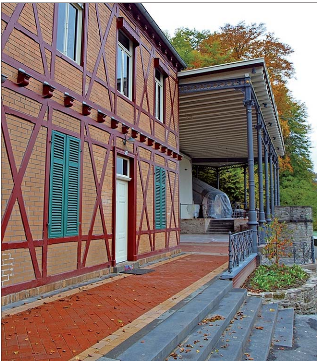
Die sanierte Talstation mit dem Café. Zurzeit steht es als Eventlocation zur Verfügung. Für den Sommer ist eine Wochenendöffnung geplant.
